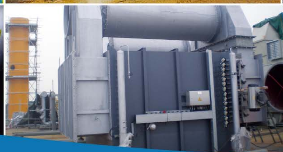
3x6000kW (3x20 MBtu/h) (WHRU) CNOOC BZ28-2 Oil & Gas Field (Offshore) 中国海洋石油CNOOC 渤中28-2油田 (海上平台)
